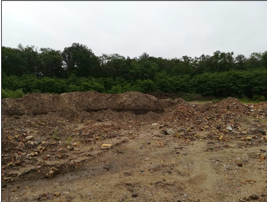
Abbildung 1 Zentrales UG, Schurf 11 sowie KRB 4, Blickrichtung Südost
