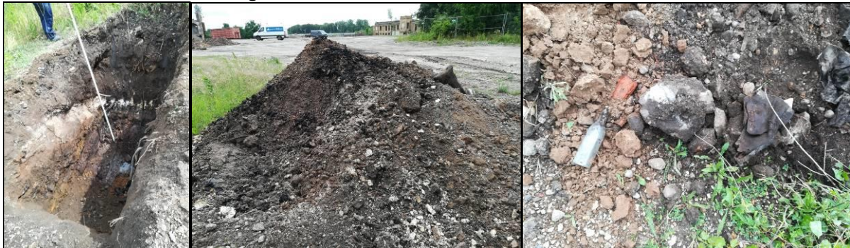
Abbildung 10 Schurf 6 sowie Aushubhaufwerk, nördliches UG
