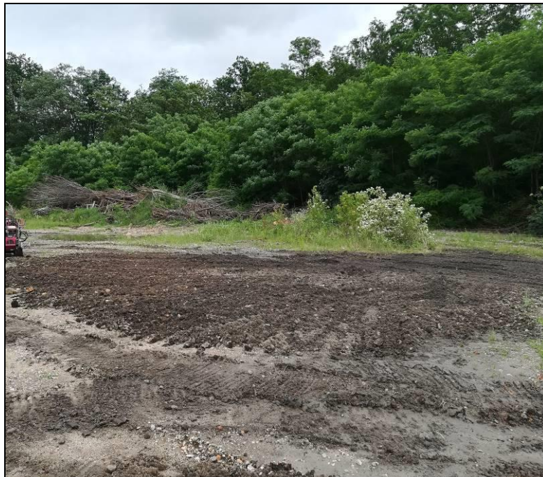
Abbildung 2 südliches UG, Bereich KRB 1 und Sch 1, Blickrichtung Südost
