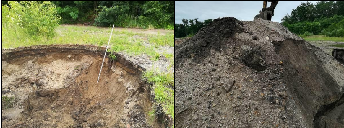
Abbildung 5 Schurf 1 sowie Aushubhaufwerk, südliches UG
