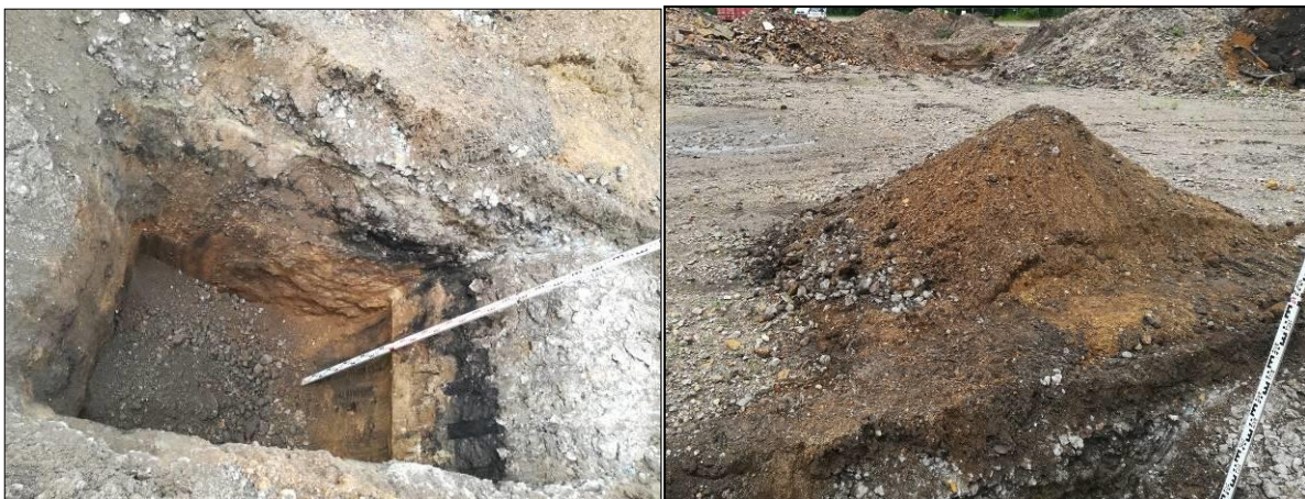
Abbildung 6 Schurf 2 sowie Aushubhaufwerk, südliches UG
