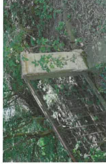
Abb. 40: Pfeiler und Handlauf. Foto, Juni 2020 (bankert&menn)
