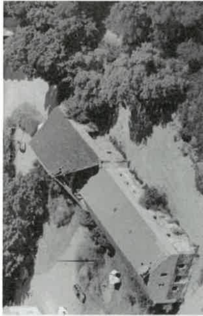
Abb. 36: Blick Richtung Osten. Historische Feldsteinscheune (Bildmitte) mit westlich anschließendem Gebäude. Ausschnitt Foto, 2009 (LDA)
