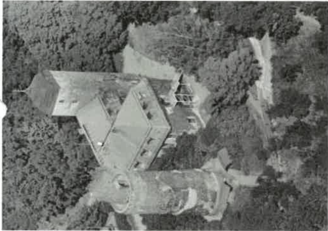
Abb. 11: Blick auf den südlichen Steilhang mit Treppenaufgang zum Roten Turm und Abstieg zum Großen Goitzschese. Foto, 2009 (LDA)
